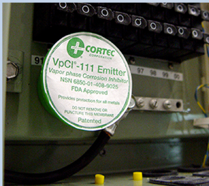
VpCI®-111: proteção de gabinetes elétricos
